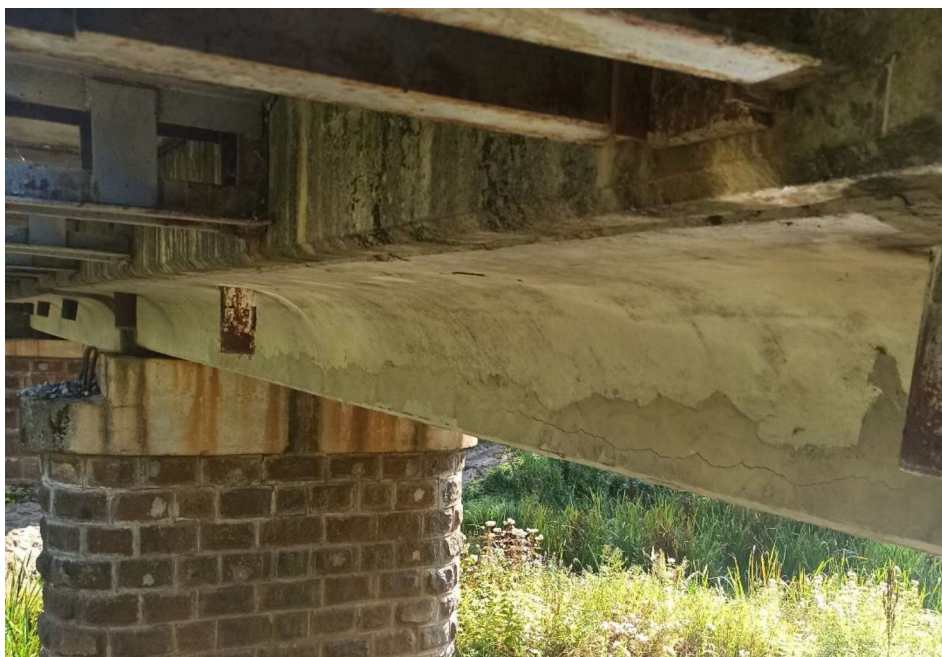
7 pav. Perdangos plokščių trūkia, išplauti kalcio karbonatai.
